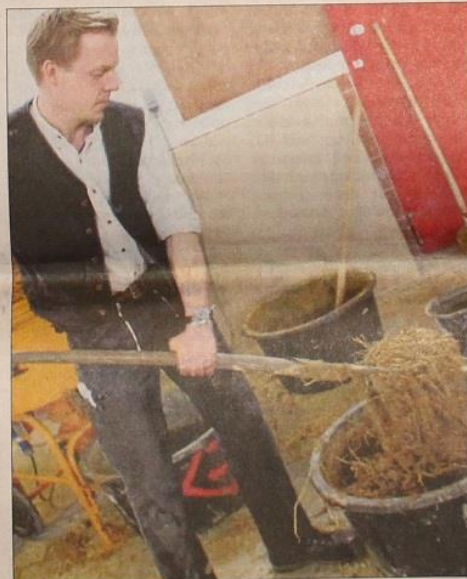
Swen Gieseke zeigt den Schülern an der BBS I in Uelzen, wie man den nassen Lehm richtig mit dem Stroh vermischt.
