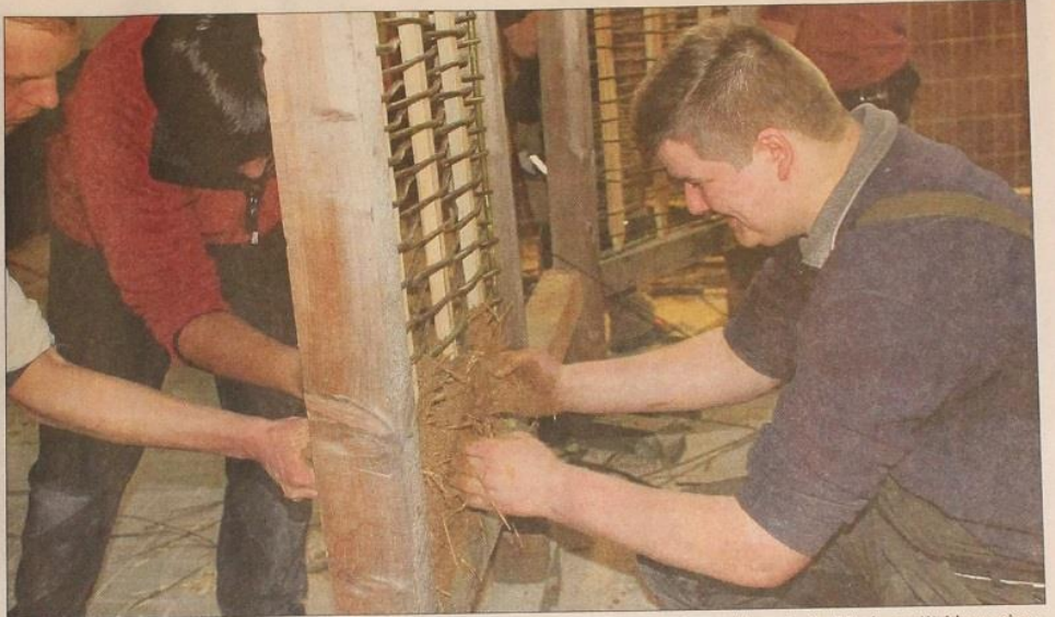
Die Schüler der BBS I packen gut mit an: Mit der Mischung aus feuchtem Lehm und Stroh verstärken sie die Wände aus Weidenzweigen. Diese haben sie zuvor in den Holzrahmen eingeflechten. Fotos: Pleuß
